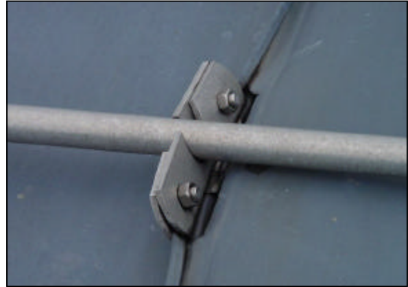
Abb. 5 und 6: Durch den seitlichen Druck des Schneefangrohres können die Blechbahnen beschädigt werden. Hier wurde eine seitliche Längenänderung von 35 mm erzeugt! Die Stehfalze können diesen unzulässigen Kräften nicht standhalten.
