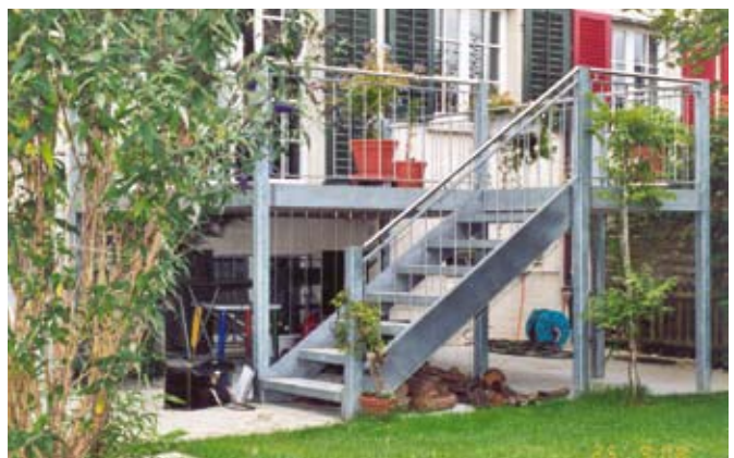
Abb 1-2: Auswahl betroffener Objekte – Balkone und Aussentreppen
