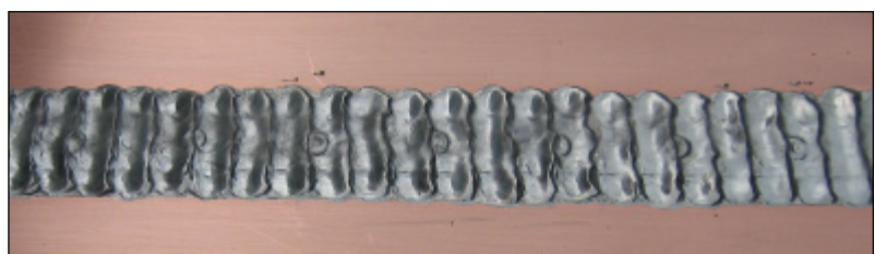
Abb. 4: Gute Baunaht. Die Zinnraupe dient vorwiegend der Erzielung der Dichtigkeit und der Ästhetik.
