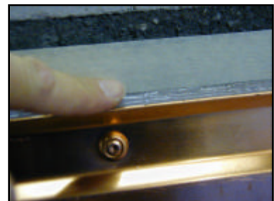
Abb. 10, 11: Den Dichtstoff sofort mit einem Spachtel oder mit dem Finger glätten. Anschliessend Abdeckbänder entfernen.
