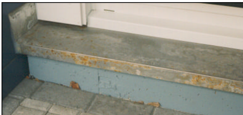
Abb. 4: Verfärbung von verzinntem Chromstahl durch chloridhaltige Fensterputzmittel.
