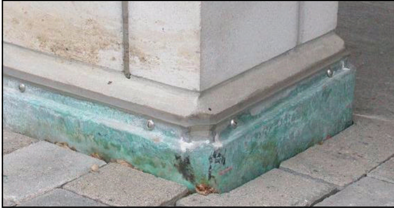
Abb. 3: Verfärbung von Kupfer verzinkt. Diese Art von Verfärbung tritt unter Einwirkung von Streusalz in Erscheinung.
