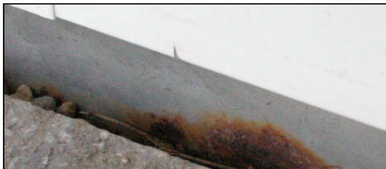
Abb. 2: Verfärbung von verzinntem Chromstahl im Flachdachbereich. Um die Zinnschicht nicht zu verletzen, ist auf eine mechanische Reinigung zu verzichten.
