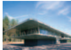
VCNON Verkehrskontrollzentrum, Wolfheze, NL De Architecten Cie, Amsterdam Verkoelen Dakbedekkingen BV, Beegden TECU® Zinn
