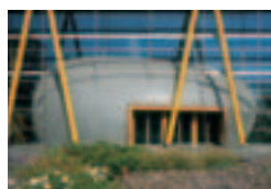
Verwaltungsgebäude WeberHaus, Rheinau/Linx Dipl.-Ing. Günter Hermann, Stuttgart Wittenauer GmbH, Sasbach TECU® Zinn
