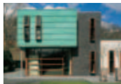
Privathaus, NL Charles Slot Bureau Ruimtelijke Vormgeving, Bergen PBK Technische Installaties BV, Alkmaar TECU® Patina
