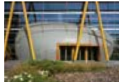
Verwaltungsgebäude WeberHaus, Rheinau/Linxs Dipl.-Ing. Günter Hermann, Stuttgart Wittenauer GmbH, Sasbach TECU® Zinn
