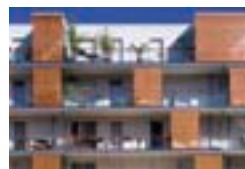
Wohnanlage „Le Galilée“, Rennes, F Chouzenoux et Associés, Rennes SABM, Guichen TECU® Net Classic
