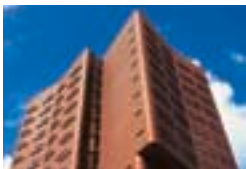
Offiziersquartier der Königlichen Marine der Niederlande, Den Helder, NL Van Herk & de Kleijn Architecten BV, Amsterdam Ridder BV, Hoorn TECU® Classic
