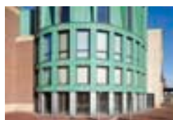
„Boscotondo“, Helmond, NL Adolfo Natalini Architetti, Florenz Architectenburo C. Schrauwen, Amsterdam Crombach Dakafwerking BV, Wittem TECU® Patina
