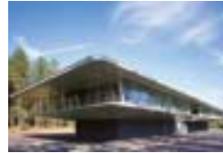
VCNON Verkehrskontrollzentrum, Wolfheze, NL De Architecten Cie, Amsterdam Verkoelen Dakbedekkingen BV, Beegden TECU® Zinn
