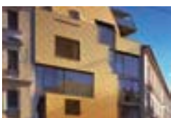
Wohn- und Bürohaus Grazbachgasse, Graz, A INNOCAD Planung und Projektmanagement GmbH, Graz Steinbauer, Judenburg TECU® Gold
