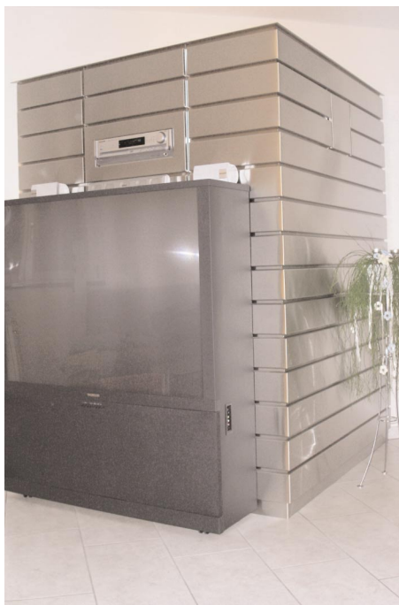
Abb. 3: Raumtrennung mit integriertem Kaminanschluss. Bekleidung: Chromnickelstahl geschliffen. Bild: suissetec, Zürich
