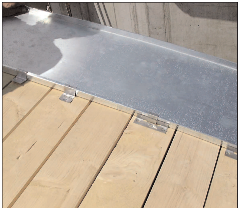
Abb. 1: Direktes Verlegen der Blechbahnen auf eine offene Schalung.
