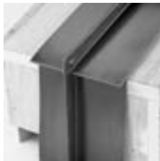
4.1.14 TRAUFE AM ÜBERGANG, FALZ DURCHLAUFEND
